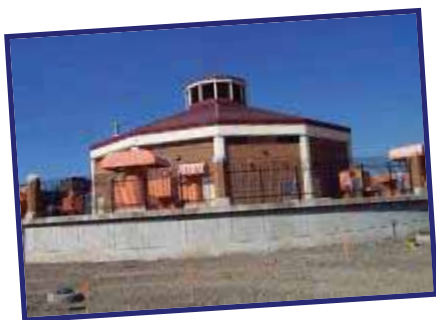
River Rouge CSO basin
